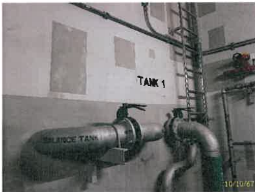
ถังสำรองน้ำใช้ เพื่อการอุปโภค-บริโภค ชั้นดาดฟ้า 1
