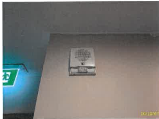
อุปกรณ์แจ้งเหตุเพลิงไหม้ด้วยเสียง และแสงไฟกระพริบ
